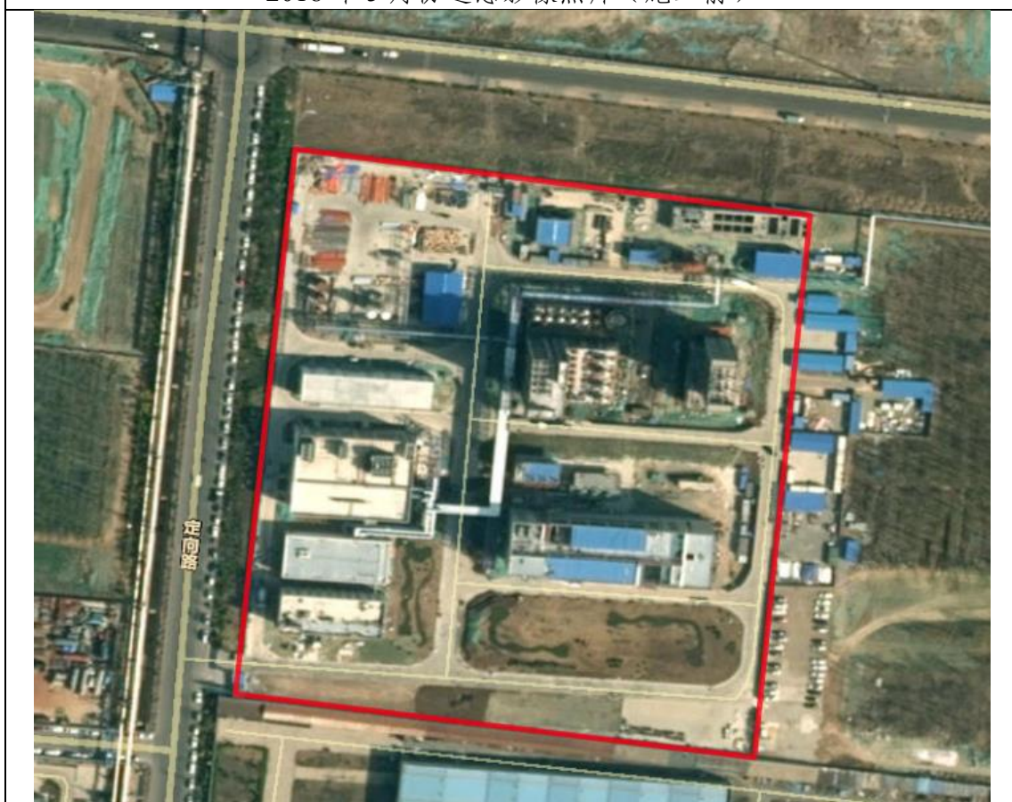
2020 年 4 月份遥感影像照片（施工中）
