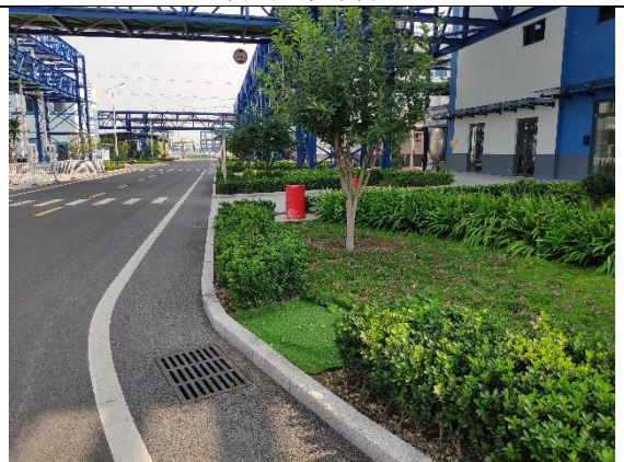
雨水排水工程
